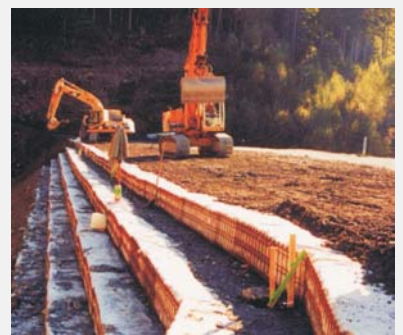
Herstellung der abgetrepten Steilböschung
